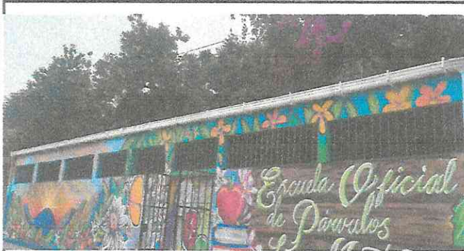
Foto1: parte de enfrente de la escuela ya remozado
