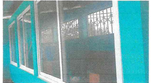
Foto 2: ventanas y pintura de la parte de adentro ya termida
