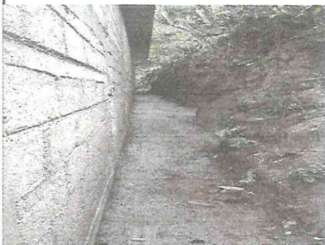
Foto 3: remodelando de la cuneta ya terminada
